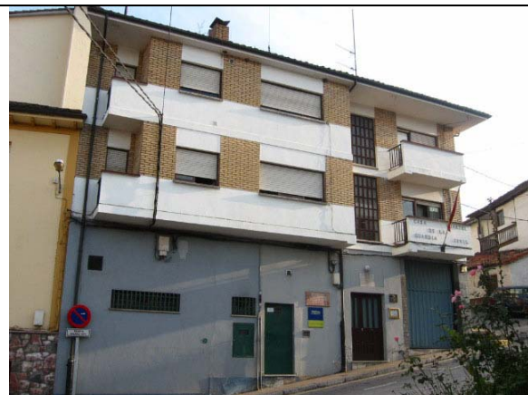
512 Instalaciones de los cuerpos de seguridad
