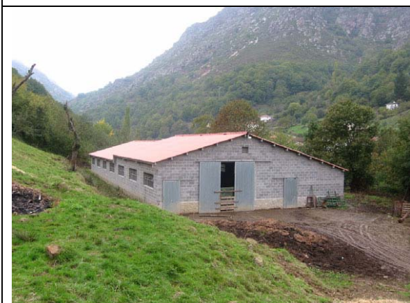
111 Edificación agrícola o ganadera
