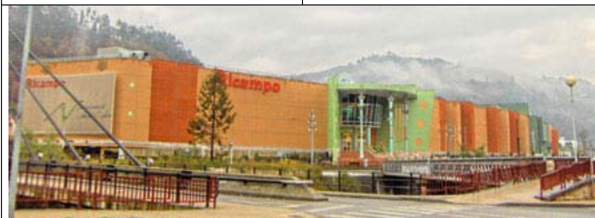
410 Instalaciones de uso comercial
