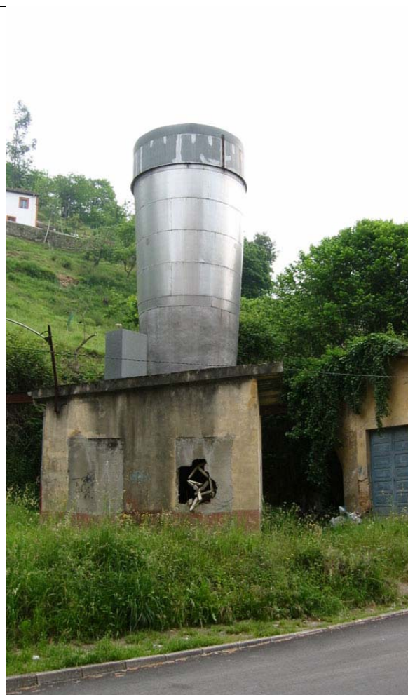
313 Instalaciones vinculadas a la minería
