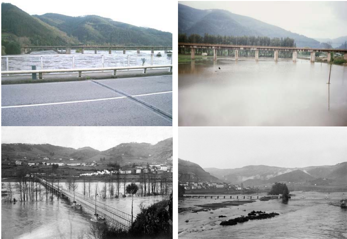
Figura 35. Diferentes inundaciones ocurridas en torno a los puentes de Pravia a través del río Nalón, correspondientes a los años 2003 y 1998 en las superiores, y a los años 1921 y 1923 en las inferiores, fechas en las que no estaba construido el puente del ferrocarril.
