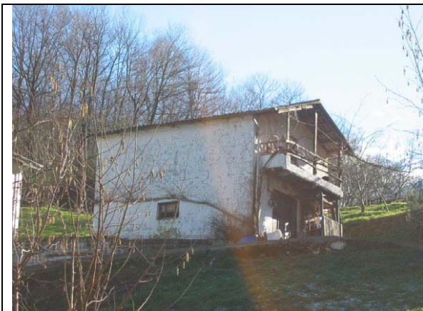
111 Edificación agrícola o ganadera
