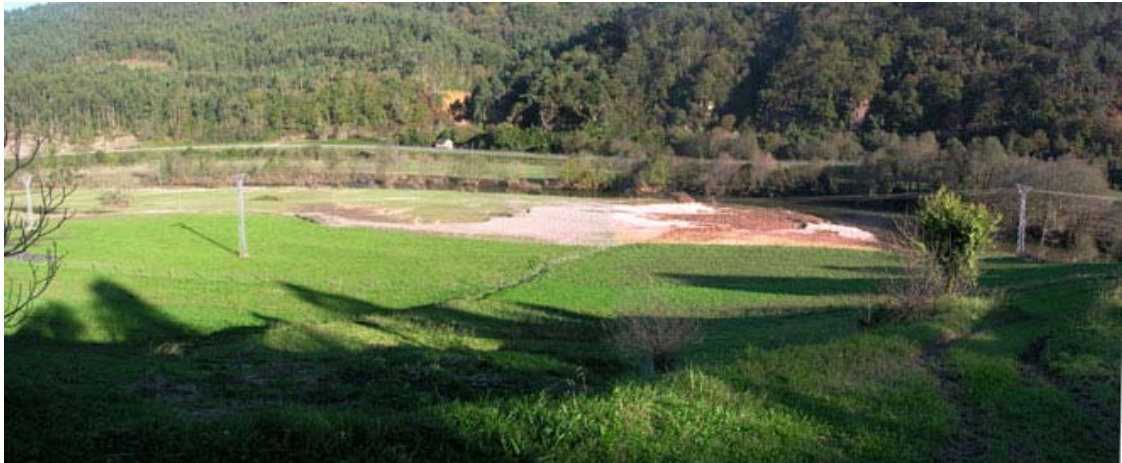
Figura 22. Formación de un canal secundario durante una avenida en la margen izquierda del río. La erosión inducida en la orilla es más favorable a los desbordamientos respecto a la situación previa.
