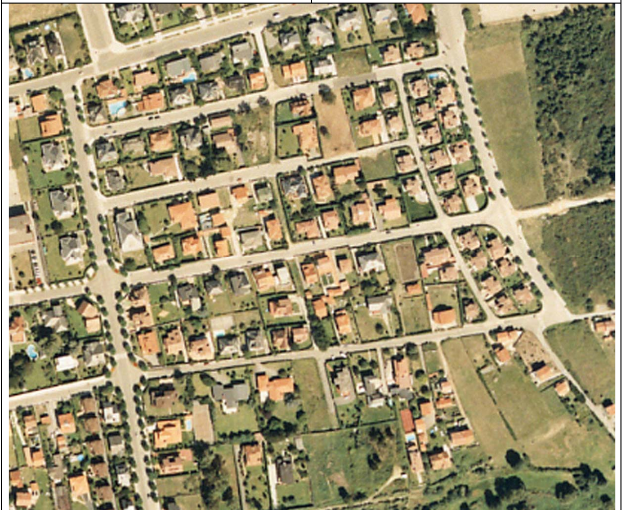
232 Área con predominio de la tipología unifamiliar
