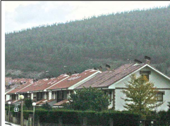
232 Área con predominio de la tipología unifamiliar
