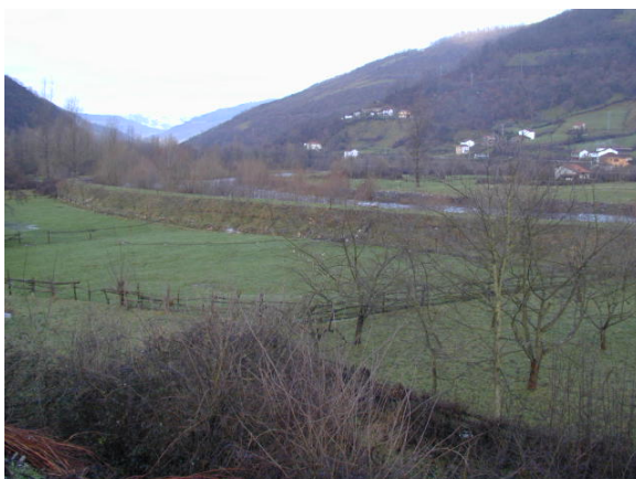
Figura 6. Trazado elevado del ferrocarril adyacente al cauce del río Aller. Restringe las inundaciones en la vega pero favorece el encharcamiento por deficiencia de drenaje.
