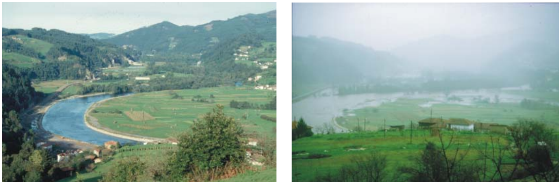
Figura 1. A la izquierda, meandro de Quinzanas canalizado. A la derecha, inundación posterior a la canalización durante una avenida en el río Narcea.
