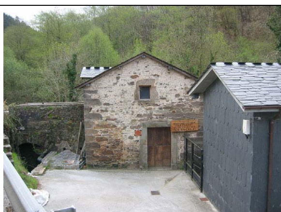
131 Instalaciones de piscicultura
