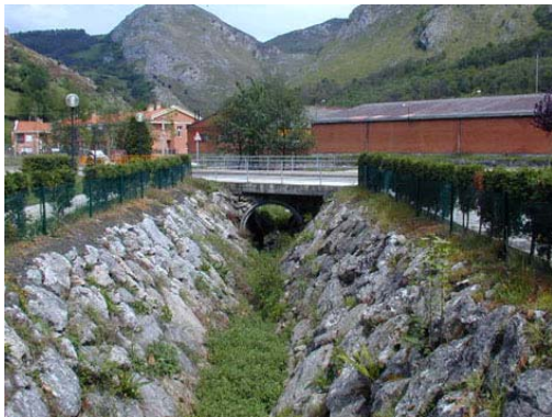
Entubación bajo infraestructura
