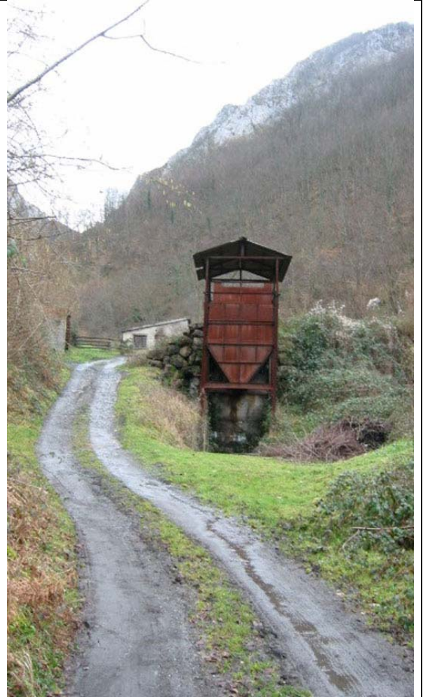
390 Instalaciones industriales sin uso
