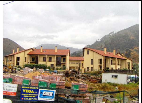
232 Área con predominio de la tipología unifamiliar
