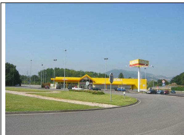
410 Instalaciones de uso comercial
