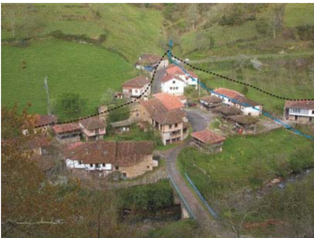
Figura 3. Torrente en la localidad de Barzana (Cuenca del río Cubia).
