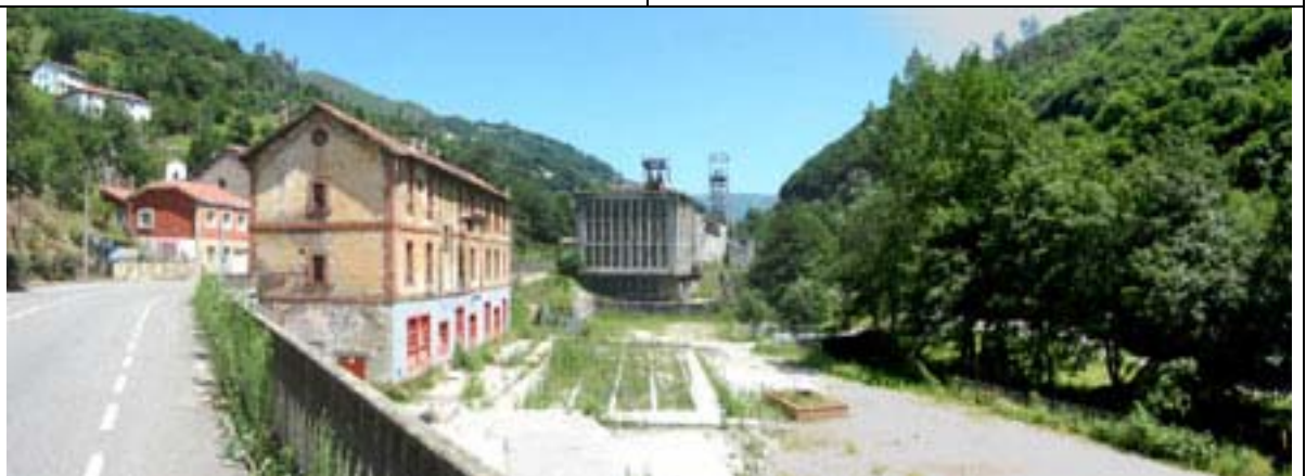
390 Instalaciones industriales sin uso
