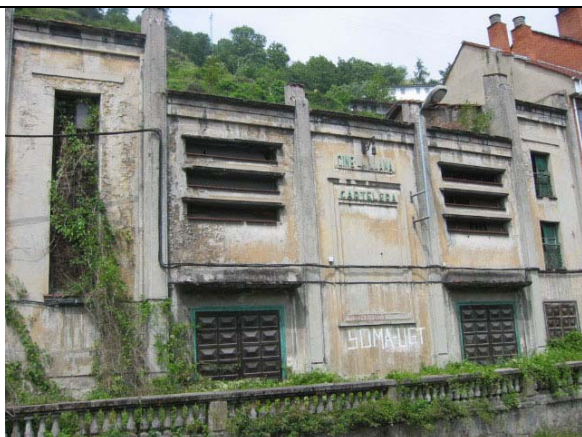
490 Instalaciones de uso terciario desocupadas
