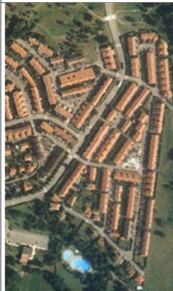
232 Área con predominio de la tipología unifamiliar
