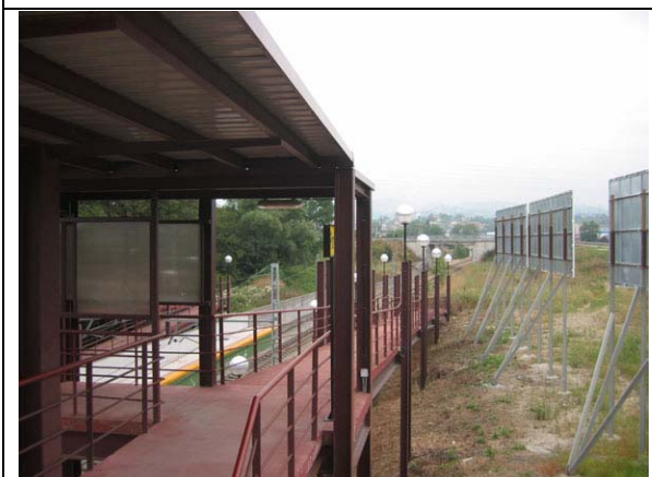
642 FEVE. Estación - apeadero
