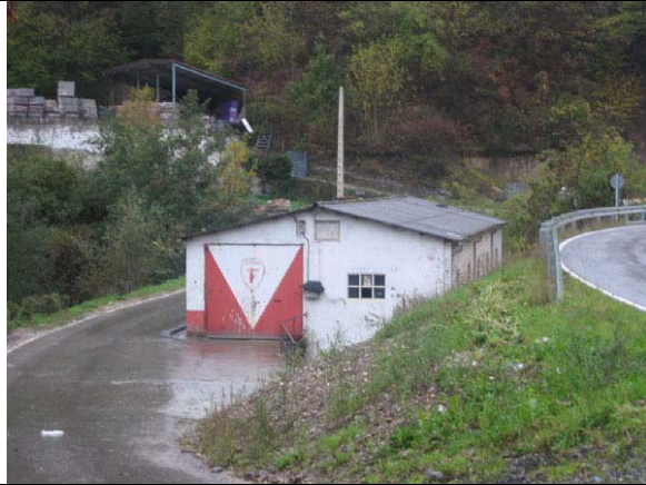
390 Instalaciones industriales sin uso
