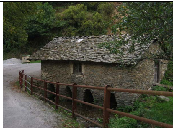
111 Edificación agrícola o ganadera
