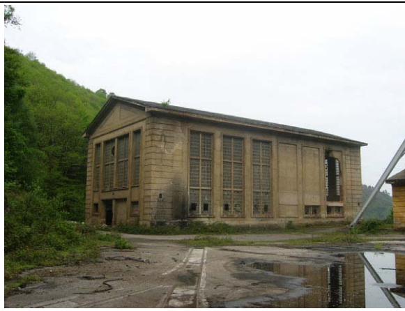
390 Instalaciones industriales sin uso
