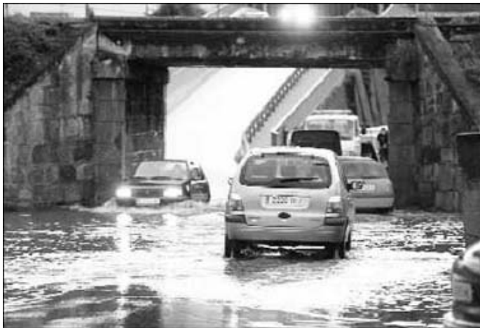
Figura 9. Inundación del paso bajo la vía de ferrocarril en Avilés debido a un episodio de fuertes precipitaciones.
