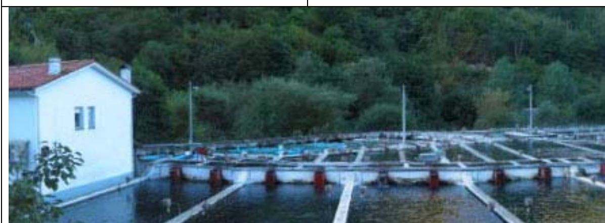
131 Instalaciones de piscicultura
