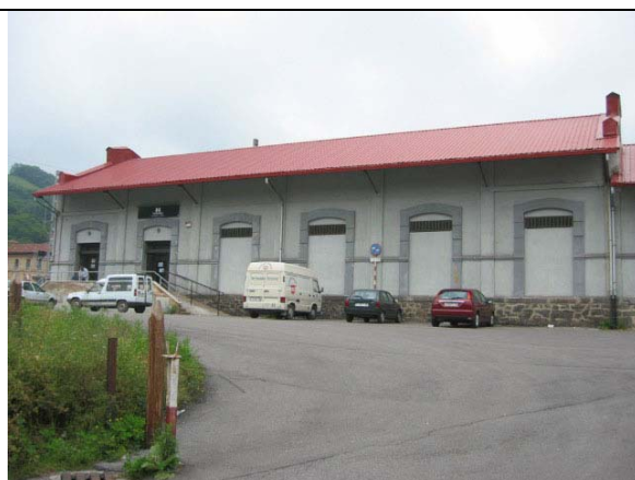
410 Instalaciones de uso comercial
