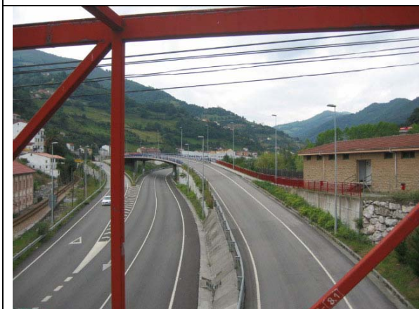
613 carreteras de la red regional
